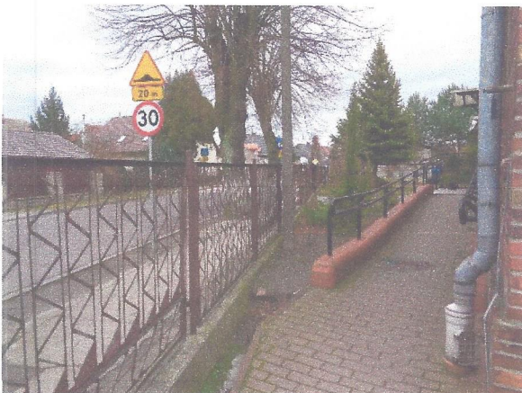
Fot. nr 29 – Ogrodzenie od ulicy – ślady korozji.
