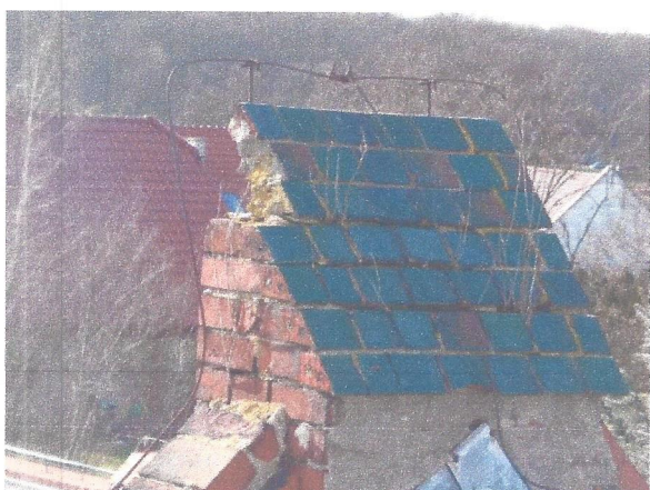
Fot. nr 17 – Pokrycie dachu – widoczne sfałowania papy na pokryciu łącznika i pęcherze papy na pokryciu sali gimnastycznej.
