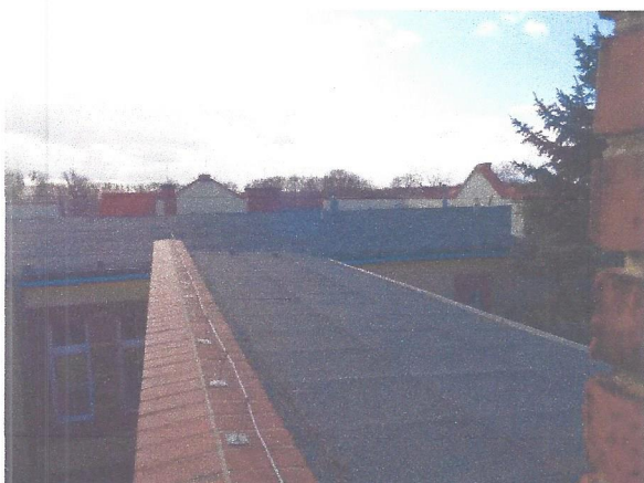
Fot. nr 17 – Pokrycie dachu – widoczne sfałowania papy na pokryciu łącznika i pęcherze papy na pokryciu sali gimnastycznej.
