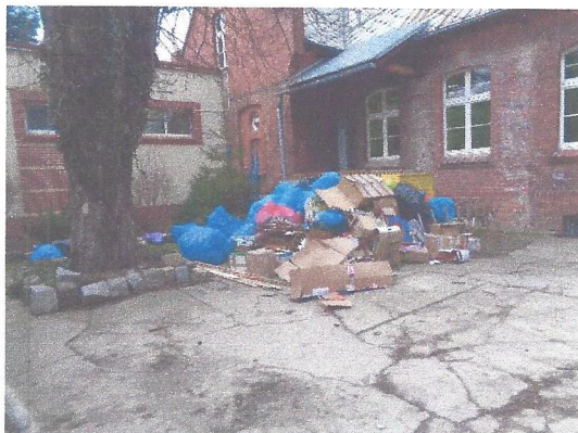
Fot. nr 33 – Popękana nawierzchnia betonowa, odpady składowane przy budynku.
