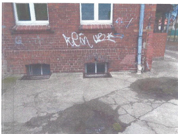
Fot. nr 11 – Wykruszone cegły nadproża okna w piwnicy. Popękana nawierzchnia betonowa.
